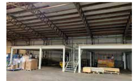
Padiglione 2, ancora in costruzione
