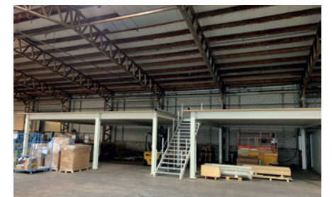
Hal 2, in aanbouw
