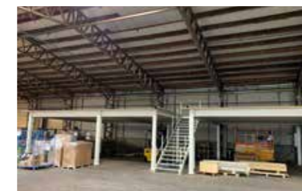
Le hall 2, encore en construction
