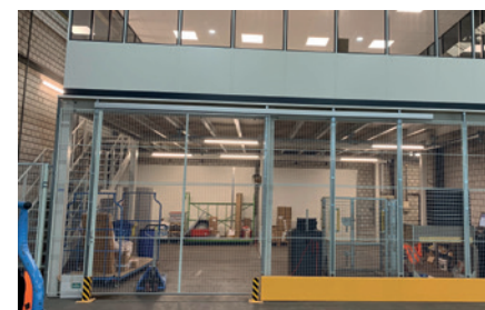
Außenansicht Schulungsraum u. Sicherheits-Zollzone
