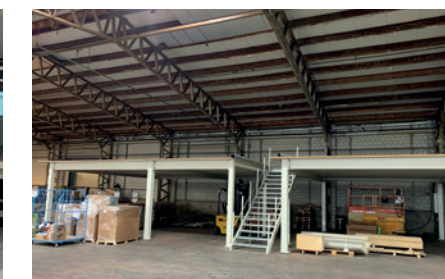
Halle 2, noch in Bau
